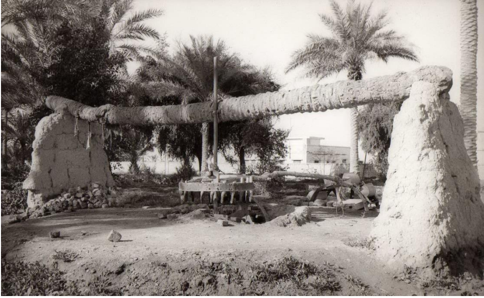
صورة رقم (٢) الناعور وكان يستعمل الى جانب الكرد لرفع المياه من النهر (او البئر) لسقى الحقول الزراعية
