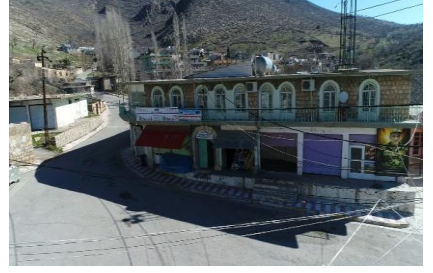
صورة ٥ الواجهة الغربية لتكية النقشبندية، باستخدام طائرة بدون طيار (Drone) - الباحثان
